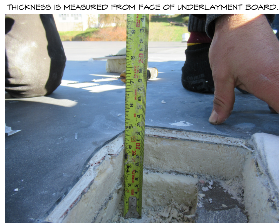
5 PHOTO 4 - EXISTING ROOF CUT SCALE: N.T.S.
