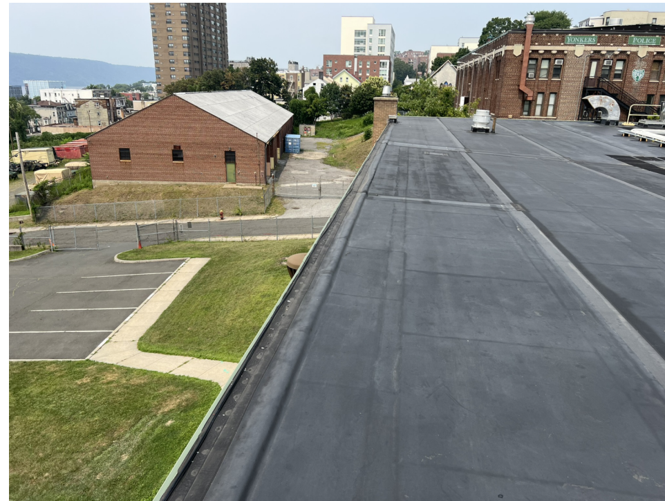
4 PHOTO 3 - WEST ROOF EDGE SCALE: N.T.S.
