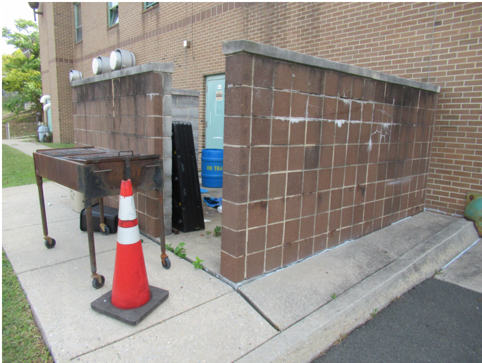
7 PHOTO 5 - WEST PATIO ENCLOSURE SCALE: N.T.S.
