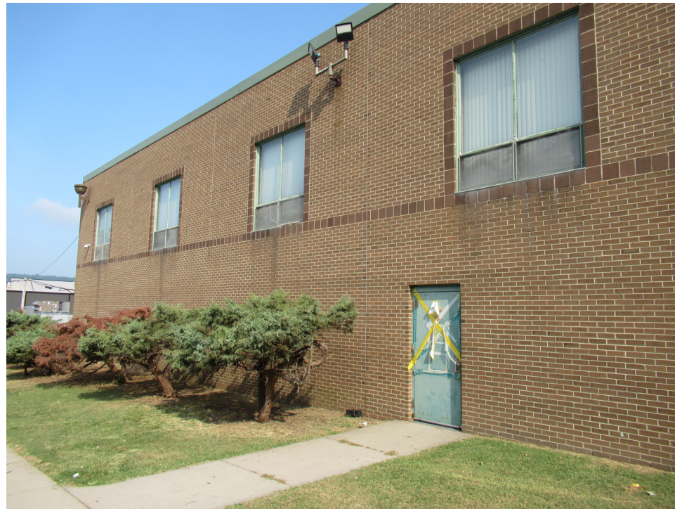
6 PHOTO 4 - SOUTH WINDOWS SCALE: N.T.S.
