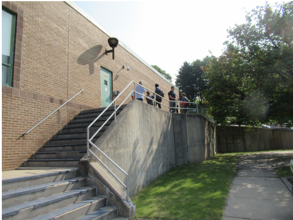
5 PHOTO 3 - SOUTH STAIRS SCALE: N.T.S.
